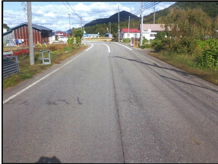
【舗装補修工事】R5市道星沢前森山線
