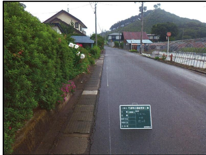
【区画線更新】R5市道北切線
