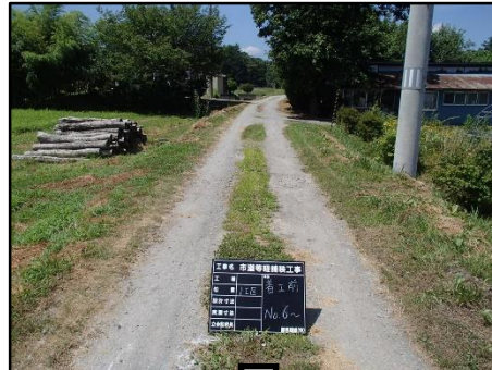
【軽舗装工事】R5大更地区
