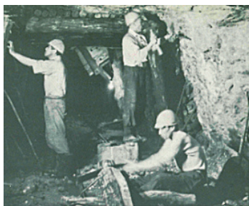
軟弱な箇所を補強する支柱手
