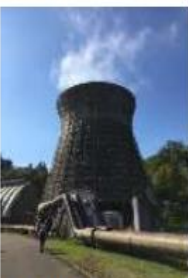
▲松川地熱発電所
