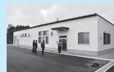
有限会社生田精密の新工場が落成し、関係者に披露されました(12月6日、大更地内)
