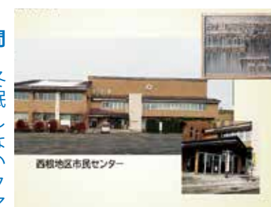
昭和56年建設の市民センター
